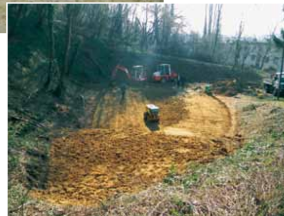
Abb. 8: 04.03.2011: Nahezu fertige Abdichtung.
