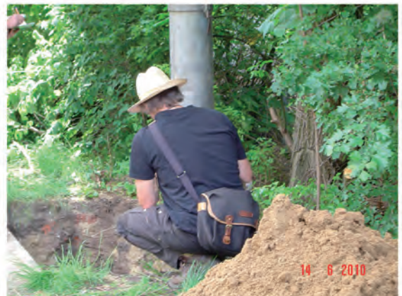
Gutachter kontrolliert den Wurzeleinwuchs in die Rohrtrasse
