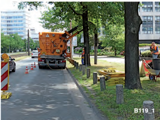
Saugbagger zum Freilegen der Rohrtrasse
