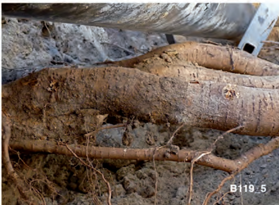
Freigelegte Rohrtrasse, gut erkennbar die starke Wurzelbildung sogar auch unter den Gasleitungen
